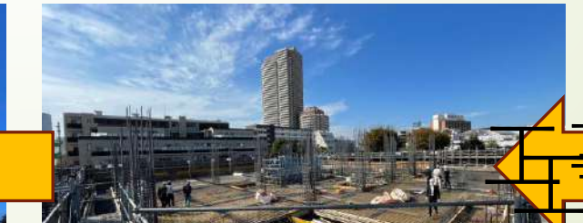
11月3F型枠工事
