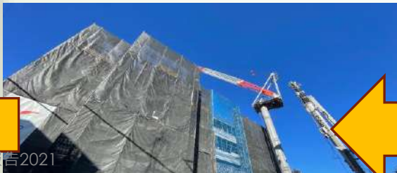
12月4F躯体工事
